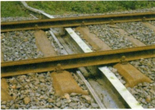
**Figura 1.** Canal de paso de sección semicircular instalado en una vía férrea alemana. Foto: Uwe Bolz (BUND-Ortsgruppe Neuss)”
